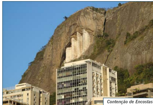
Contenção de Encostas
