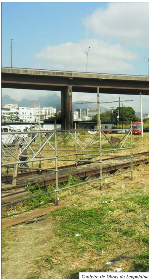
Canteiro de Obras da Leopoldina
